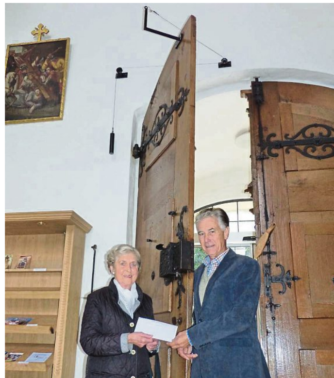
Rosi sei Dank: Mit dem von Rosi Haseitl finanzierten Seilzug ist der südliche Eingang in die Stadtpfarrkirche Mariae Himmelfahrt endgültig barrierefrei. Helmut Hunger freut's.
